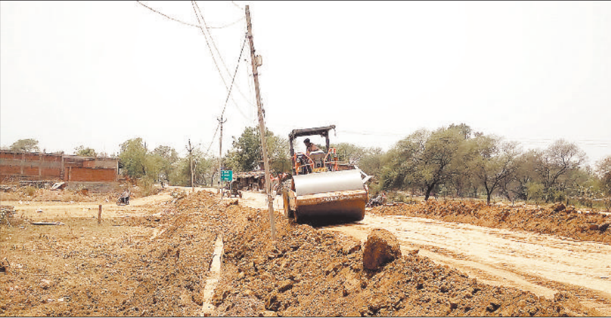
चल रहा सड़क निर्माण कार्य।
